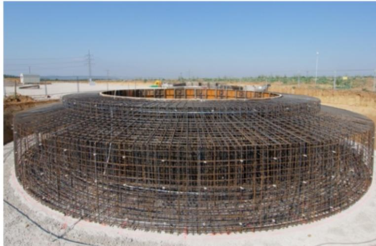
Kein ganzer Hektar: Fundamentbewehrung einer Windkraftanlage (hier: 1,0 MW-Anlage in Schonungen). Quelle: Wikipedia.
